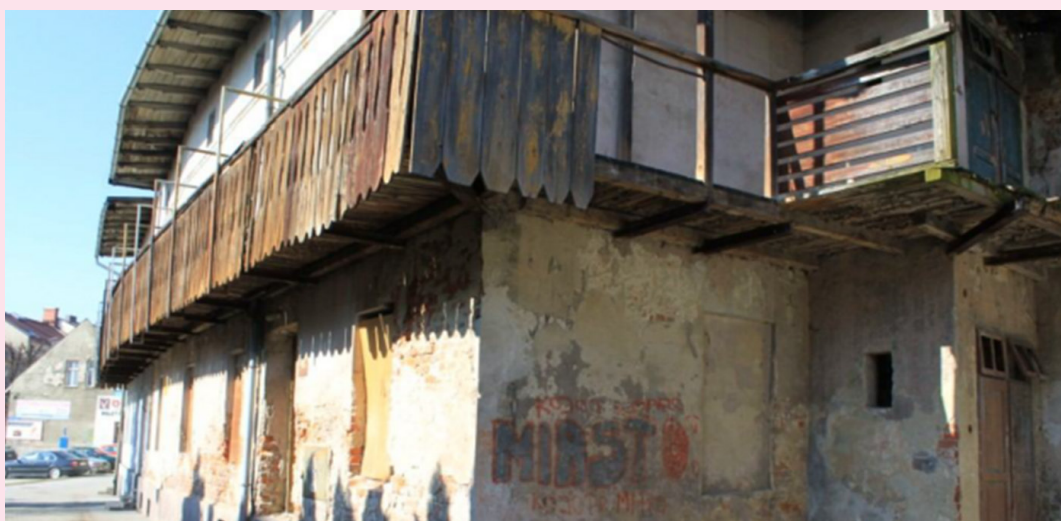
Ryc. 12. Oświęcim, Plac Słoneczny 4, przed przebudową Źródło: Oświęcimskie TBS
