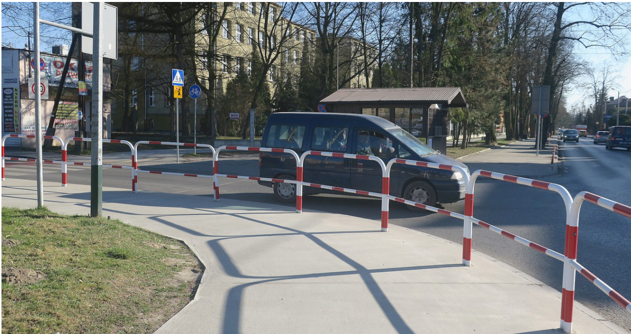
Ryc. 3. Błędne i nieczytelne rozwiązanie drogi dla rowerów i przejazdu dla rowerzystów na skrzyżowaniu ul. Żwirki i Wigury (po prawej, na wprost) oraz Konstytucji 3 Maja w Skawinie Źródło: archiwum autora
