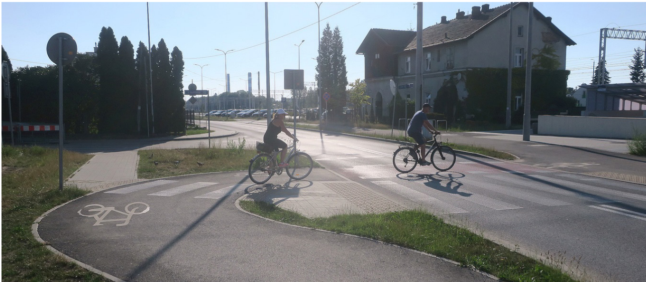
Ryc. 6. Droga dla rowerów wzdłuż ul. Kolejowej w Skawinie
